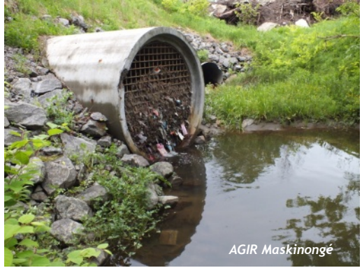
Sortie de conduite pluviale dans le ruisseau Comeau à Saint-Gabriel
