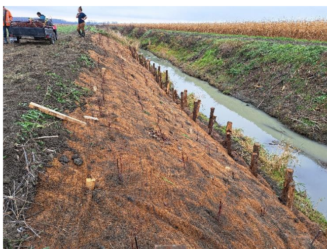
Figure 8 : Travaux de stabilisation du littoral et des rives de la rivière du Bois-Blanc par bouturage, octobre 2024
