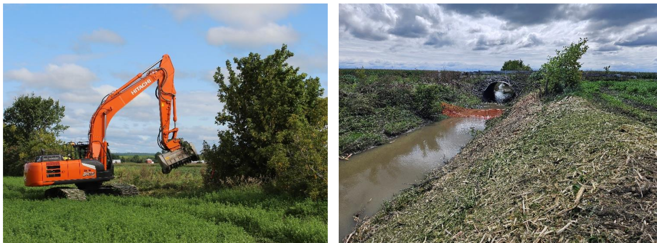
Figure 2 : Broyage des érables à Giguère réalisé par une pelle mécanique muni d'un broyeur forestier, août 2024
