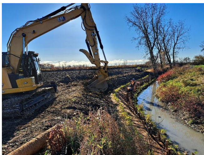
Figure 7 : Travaux de stabilisation du littoral et des rives de la rivière du Bois-Blanc par lits de plants et plançons, octobre 2024
