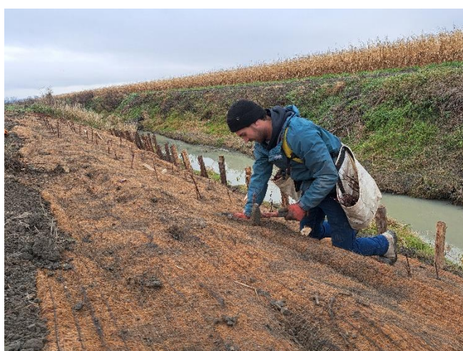
Figure 8 : Travaux de stabilisation du littoral et des rives de la rivière du Bois-Blanc par bouturage, octobre 2024
