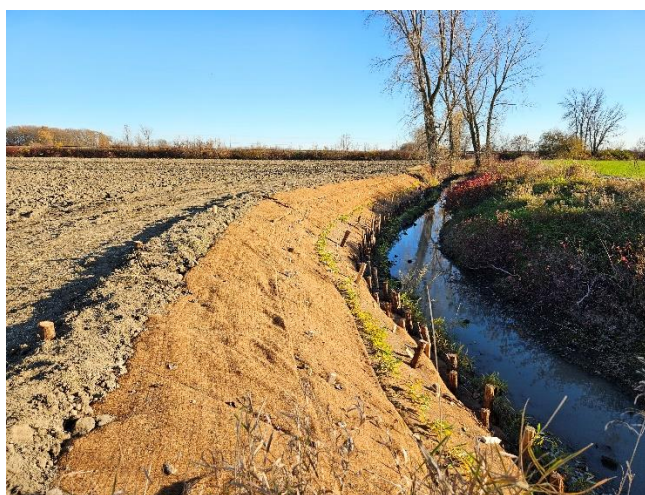
Figure 7 : Travaux de stabilisation du littoral et des rives de la rivière du Bois-Blanc par lits de plants et plançons, octobre 2024
