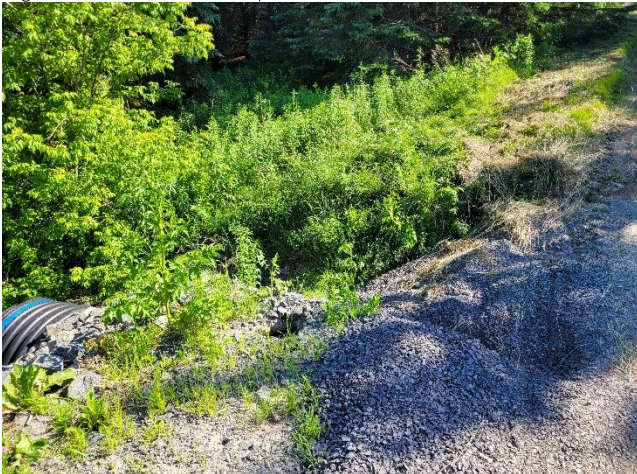
Figure 6. Suivi de l'état des ponceaux
