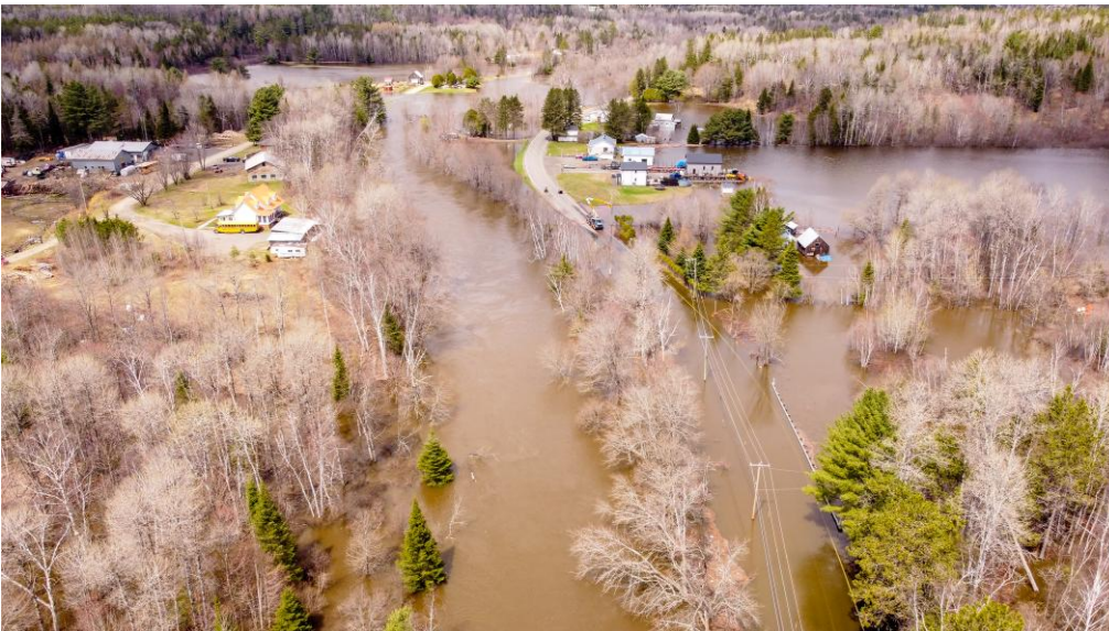
Figure 6 : Coupure de la seule route vers le nord de Mandeville par les inondations de 2023
