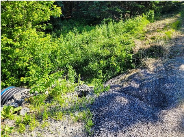
Figure 6. Suivi de l'état des ponceaux
