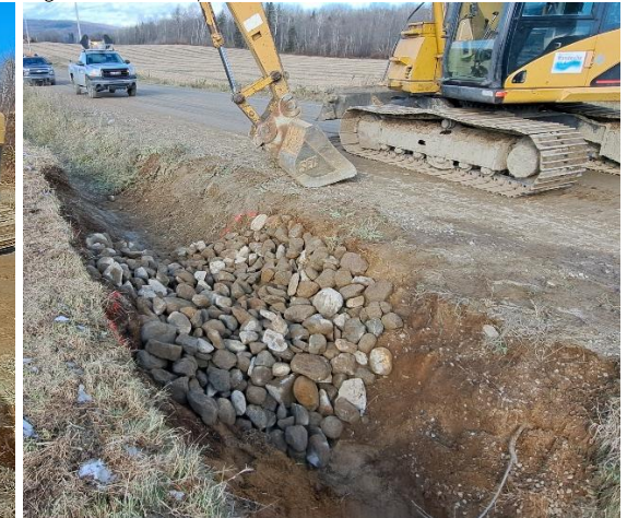
Figure 8. Technique de lutte contre l'érosion dans un fossé
